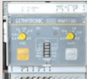
INTERRUTTORE DIFFERENZIALE EARTH FAULT BREAKER
