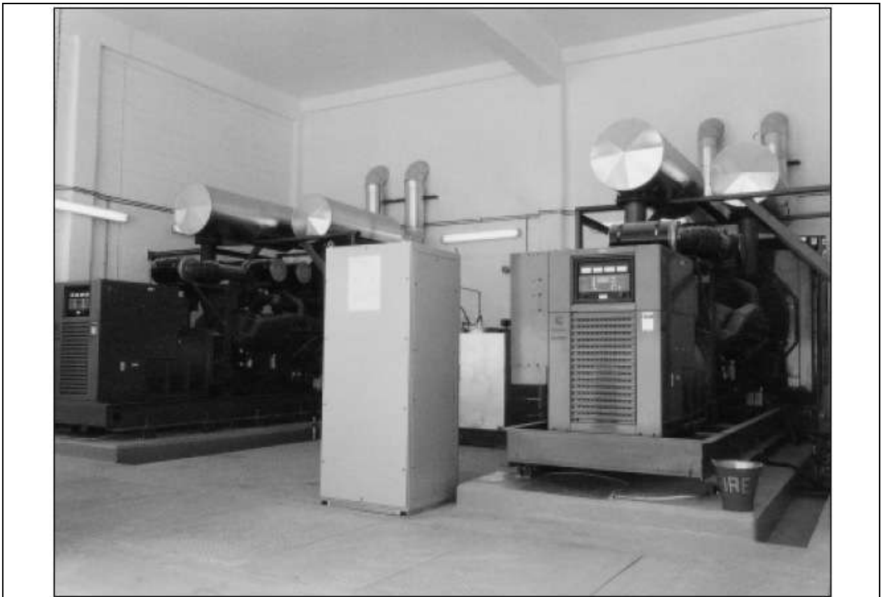
Генераторы, работающие независимо от внешнего источника питания и подключенные параллельно.
