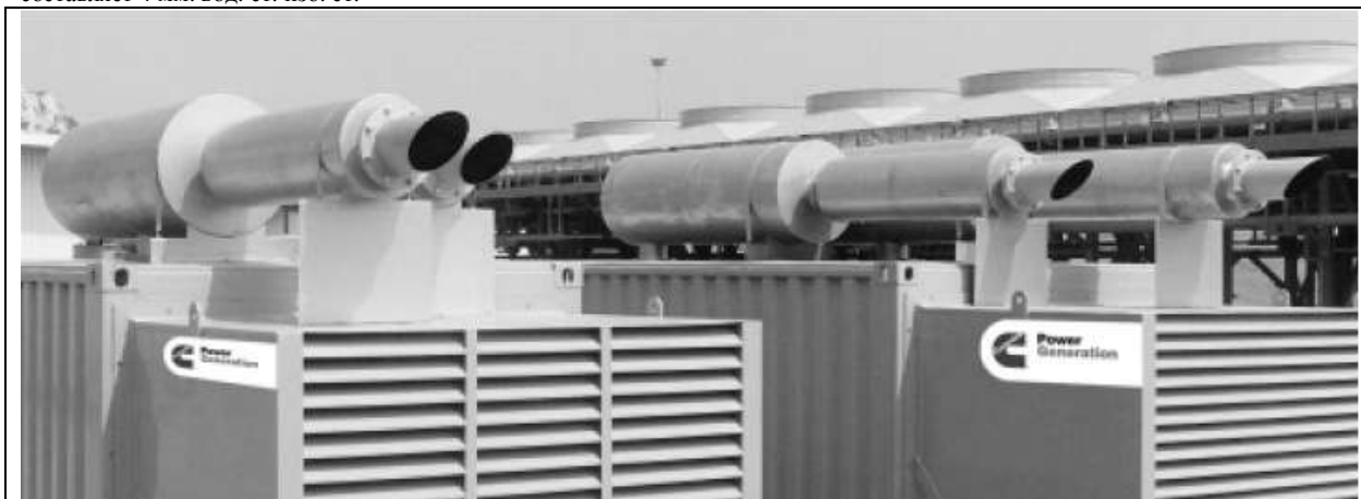
Комбинация стационарного и стандартного глушителя в форме выпускной трубы обеспечивает эффективное шумоподавление
