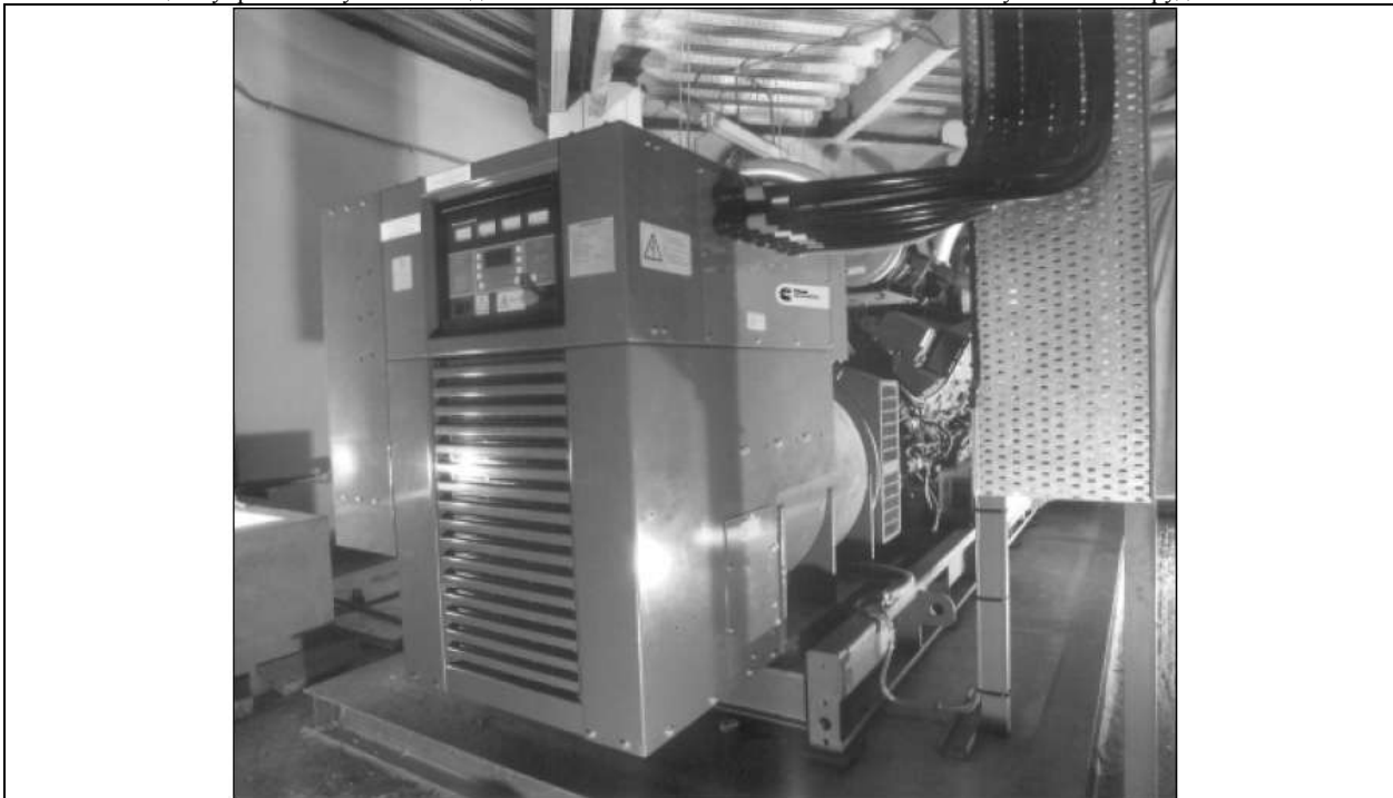
Подводка гибкого кабеля к модулю управления и кабельный канал для подводки сбоку.
