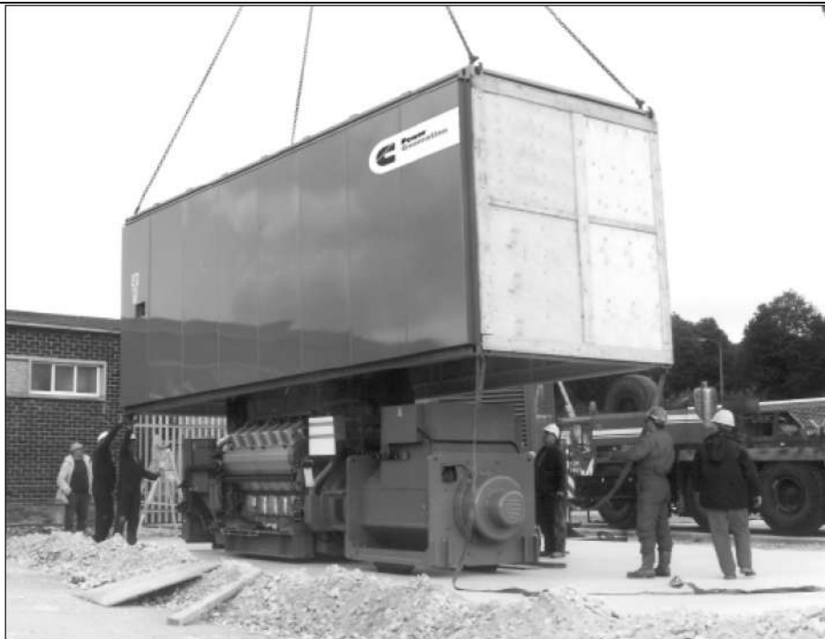
«Надеваемый» сверхмощный корпус для генератора первичного питания мощностью 3700 кВт устанавливается на специально подготовленное цементное основание.
