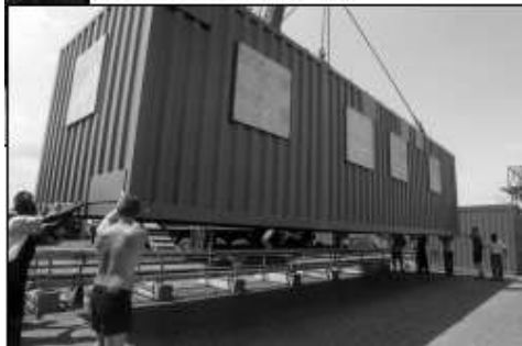
Транспортировка, разгрузка и установка любого оборудования осуществляются специалистами Cummins, которые могут также взять на себя его эксплуатацию и техобслуживание.
