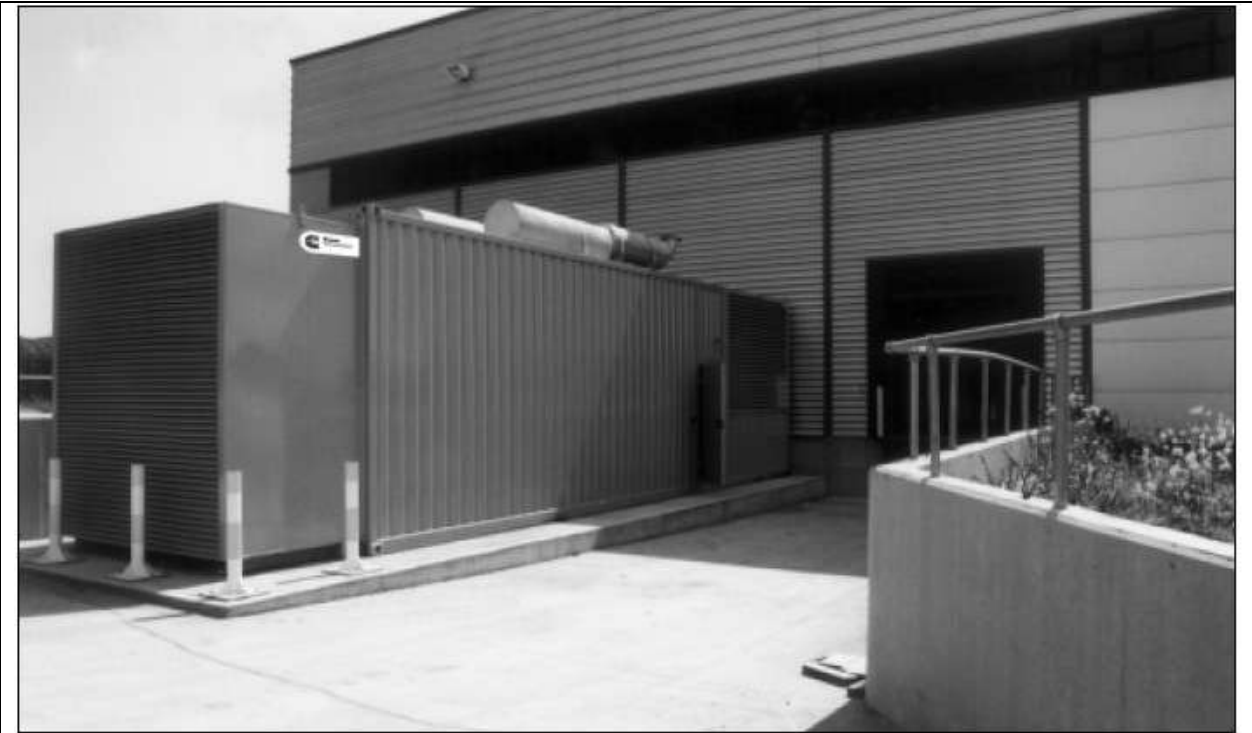
Малозумный контейнерный корпус длиной 12 м (40 футов) с генератором на 2000 кВА. Низкий уровень шума допускает установку поблизости от здания, уменьшая длину кабеля.
