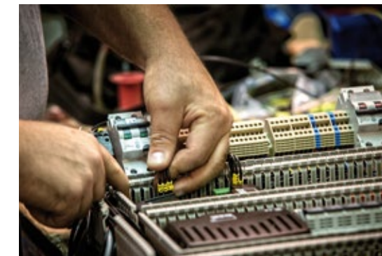
es Área de fabricación de cuadros eléctricos.
