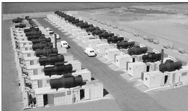
**Дизельная генераторная станция мощностью 60 МВт, оснащенная двухтопливной системой GTI, восполняющая потребности энергии в период пикового потребления**
